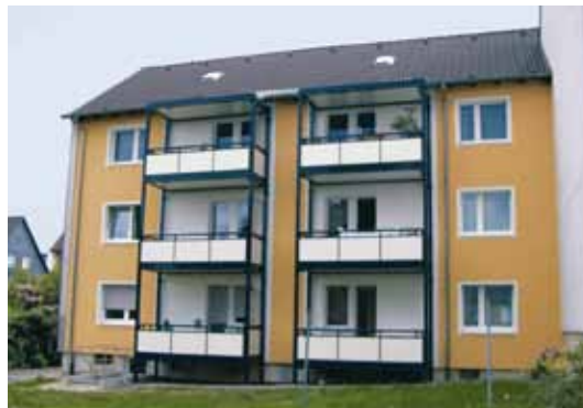
... und neue Balkone
