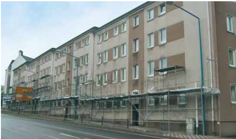
Friedrich-Ebert-Straße 1-7 während des Gerüstaufbaus
