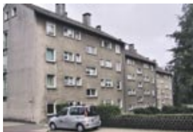
Eingangsseite vorher und nachher
