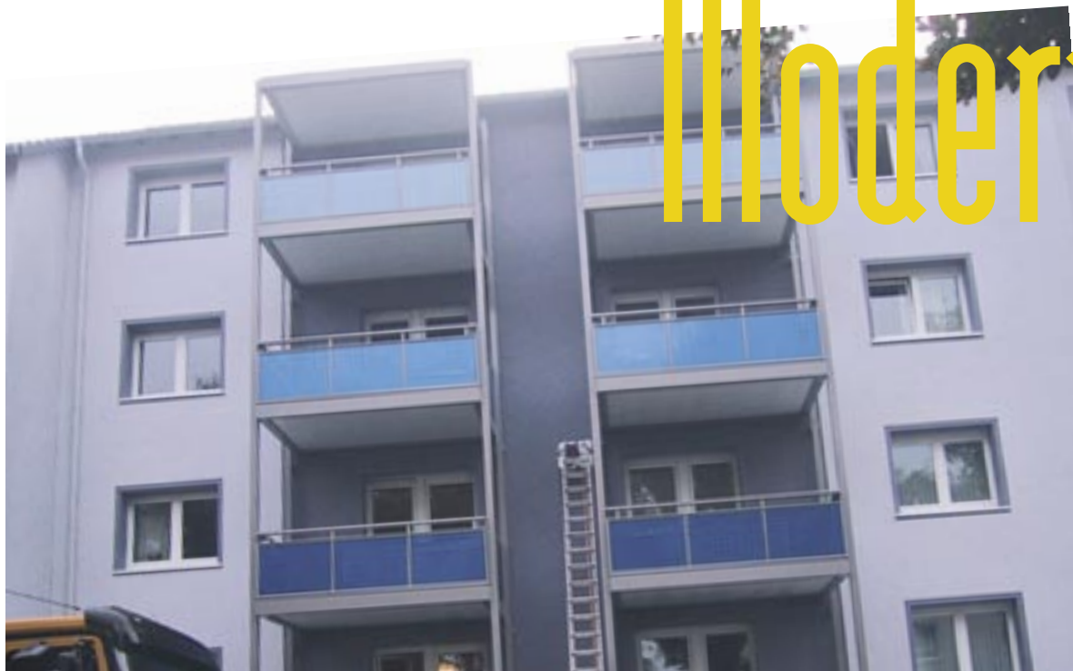
Die neue Fassade und neue Balkone
