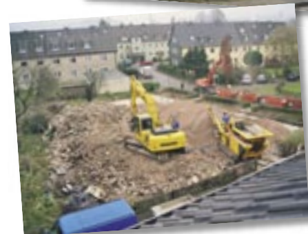
Lortzingstraße 2+4 vor, während und nach dem Abriss
