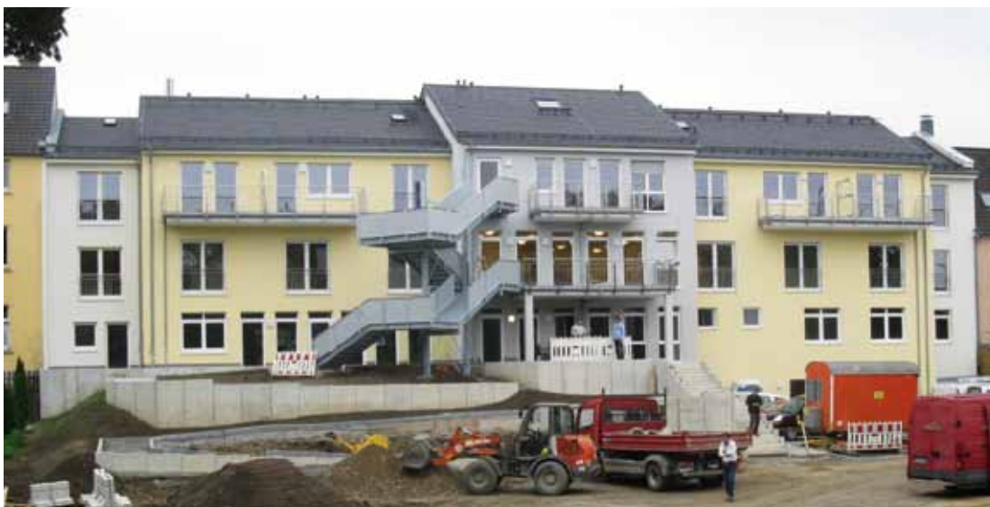
Unten: Die Rückfront – geprägt durch eine mächtige Stahlterrasse (Rettungsweg)
